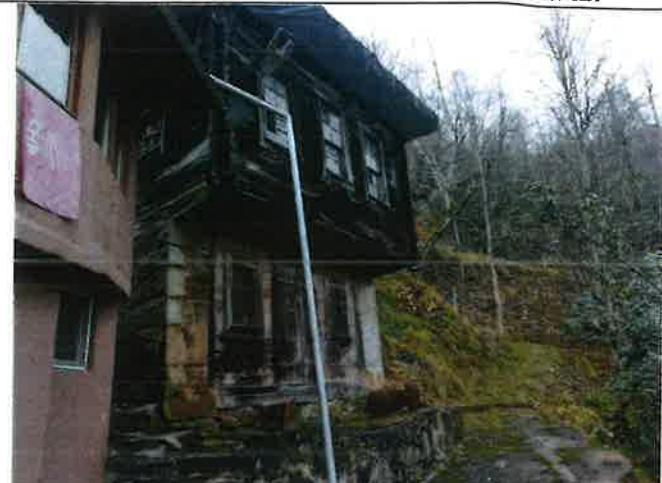
**GÖZLEMLER:** Genel olarak bakımsız olup çatısında ve ahşap malzemelerinde çürümeler mevcuttur.
