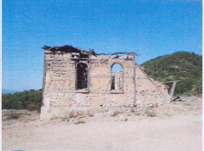
Taşınmazın doğu cephesinden görünüşü
