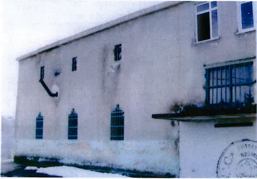
Trabzon ili, Beşikdüzü ilçesi, Akkese Mahallesi, 122 ada 9 parselde bulunan Akkese Mahallesi Merkez Camii (doğu cephe)
