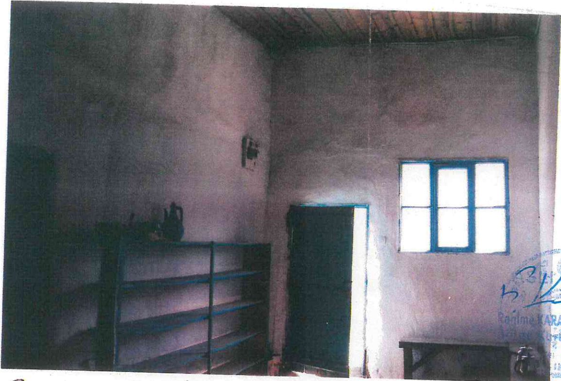
Camiye giriş kapısının içeriden görünümü.
