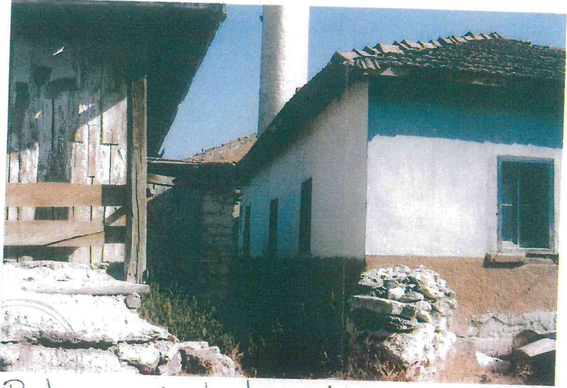
Batı ve güneybatı cephe.
