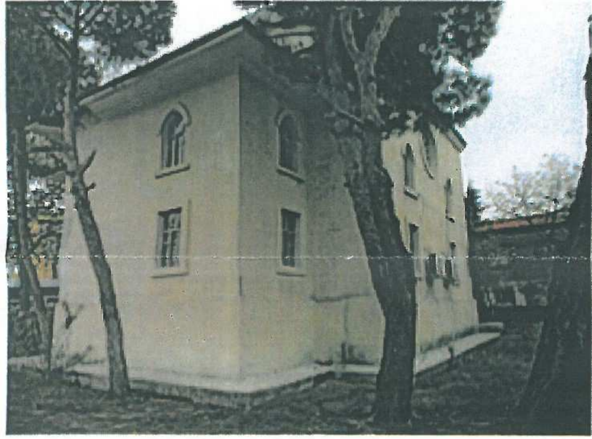
Sağ yan cephe ve arka cephe
