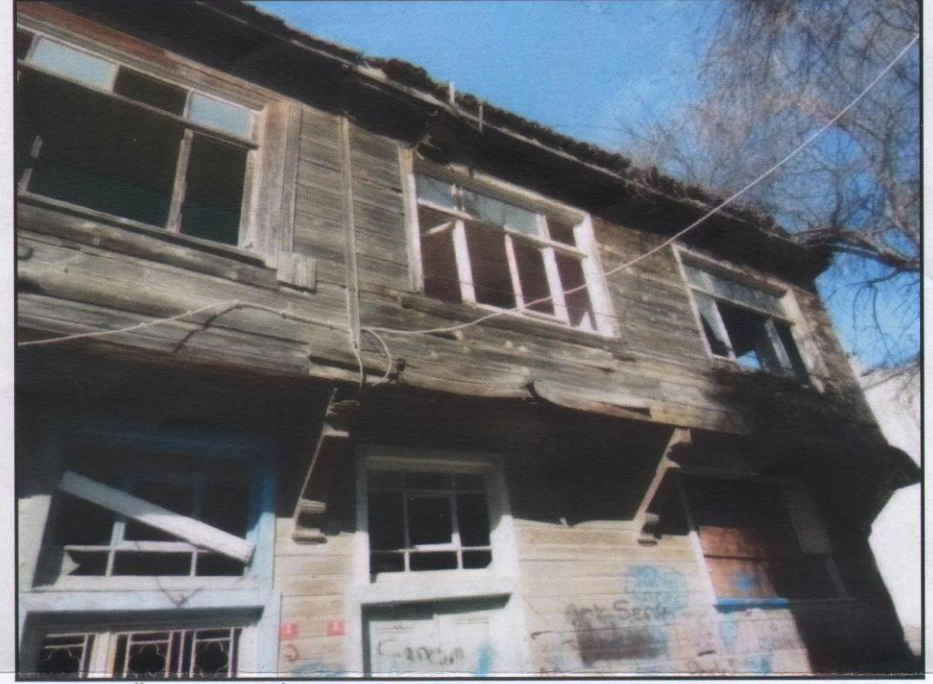
YAPININ ÖN CEPHESİ (Doğudan, Hakan Sokaktan)
