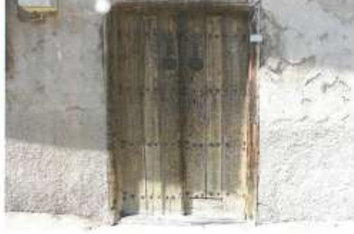
Foto 2: Evin çift kanallı ahşap kapısından görünüm.
