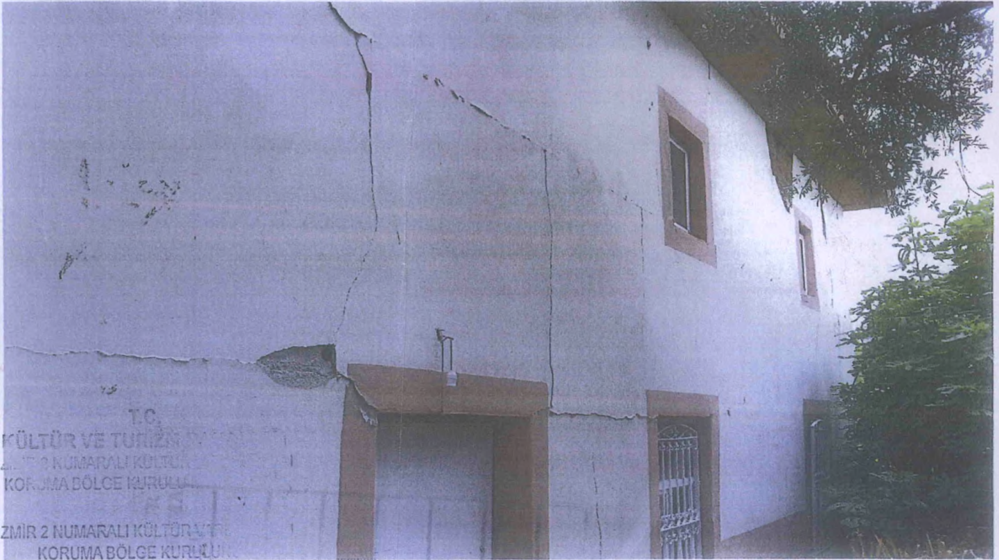
Batı cephesi ve duvarda meydana gelen çatlaklar
