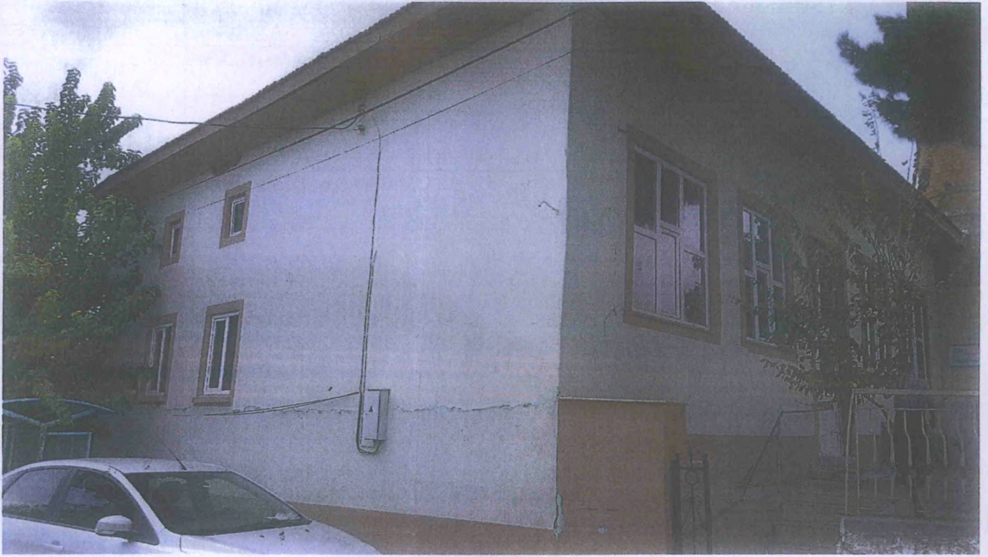
Kuzey doğu cephesi
