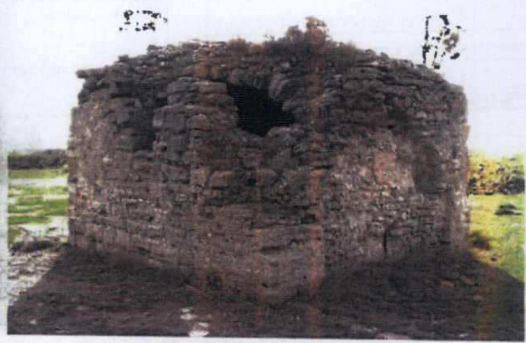
Caminin güneyinde yer alan çeşmeden bir görünüm
