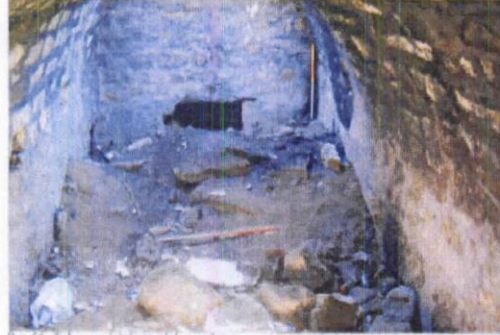
Res.56- Tabyanın içinin temizlenmeden önce görüntüsü.
