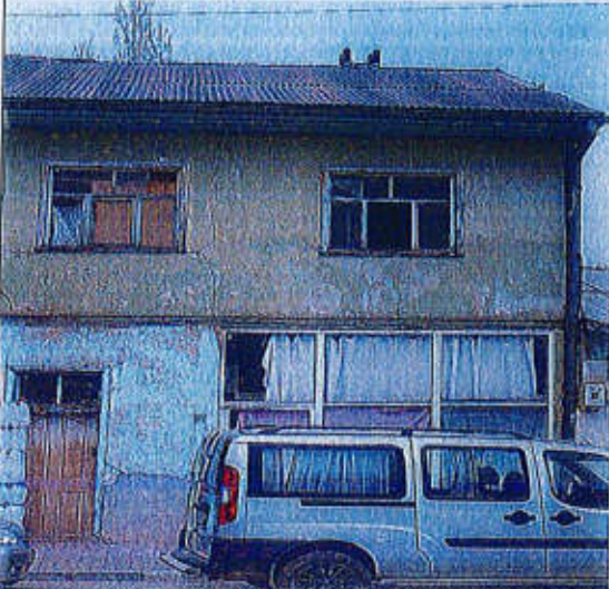
Gözlemler: Zemin +1 katlı dikdörtgen planlı bir yapı olup alt katı dökülmüştür.
