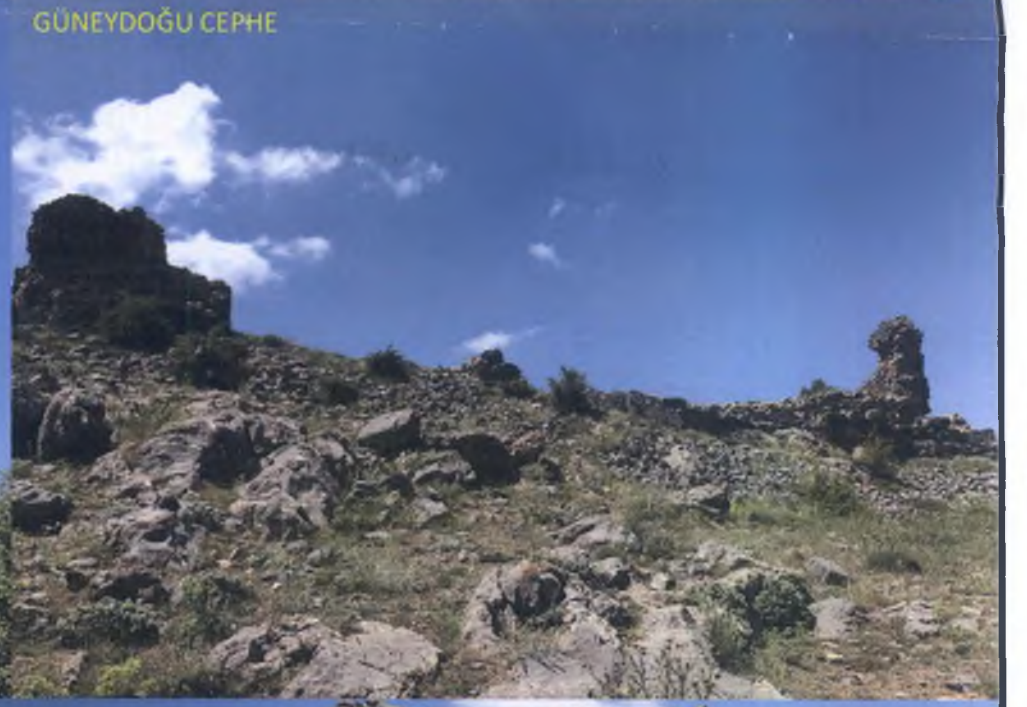
KALENİN İÇ YÜZEYİNDEN GÖRÜNÜM
