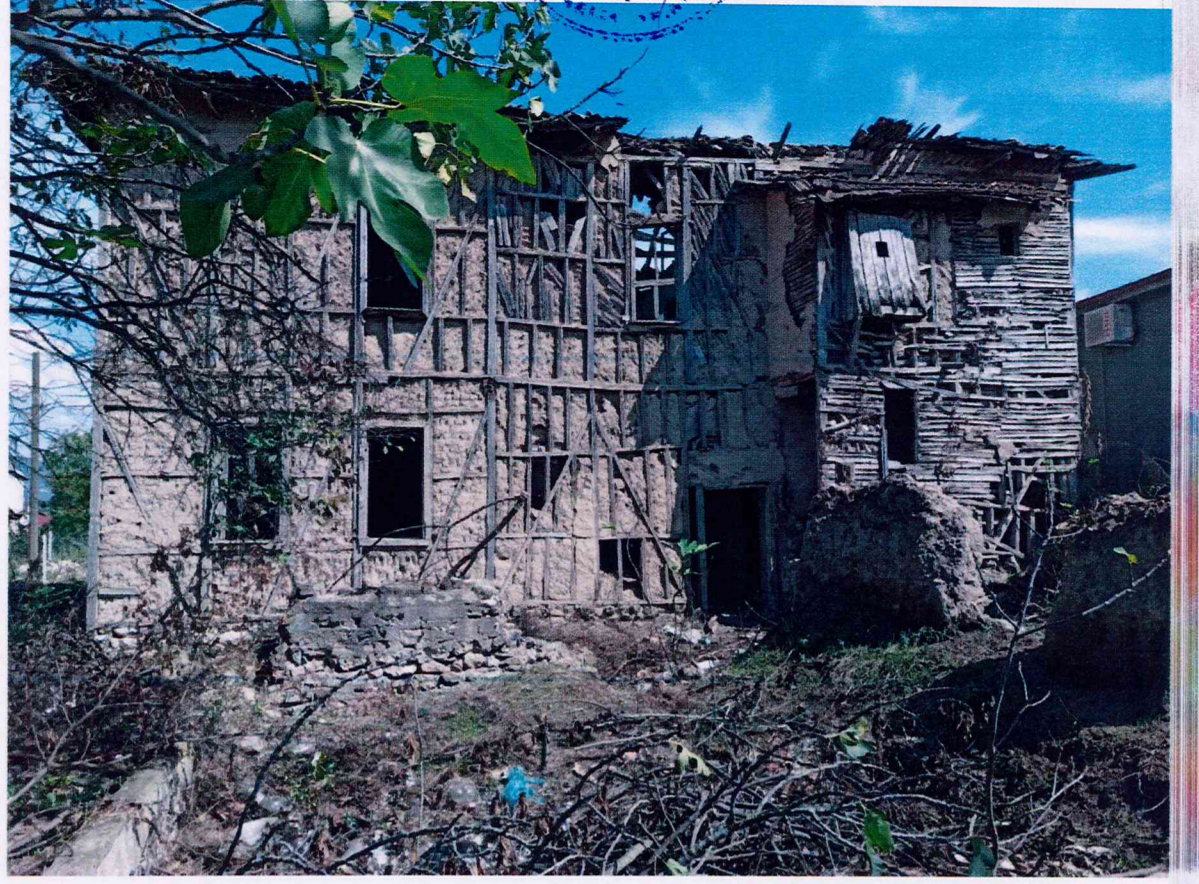
Fotoğraf 2: Yapının güneybatı cephesi
