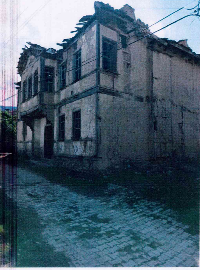
Fotoğraf 1: Yapının kuzeydoğu ve kuzeybatı cepheleri
